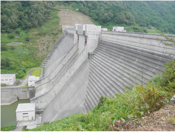
↑ダム本体（堤体）
