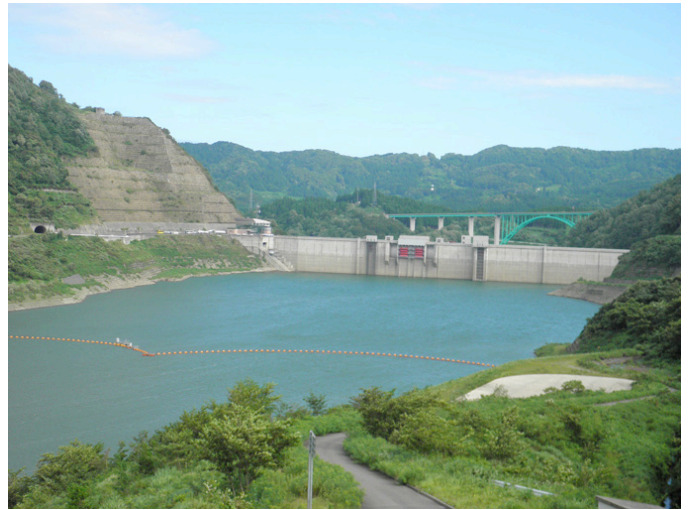
↑国道 112 号線（ダム湖）側から見た ダム本体（堤体）
