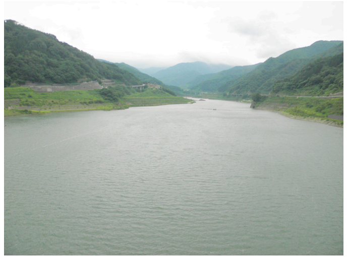
↑ダム本体（堤体）から見たダム湖
